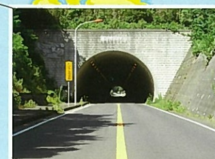
延長278mの毘沙門トンネル。
